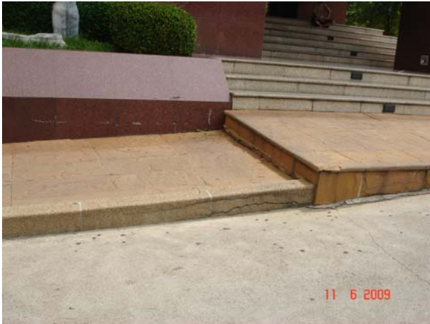
รูปที่ 1 แสดงการทรุดตัวของพื้นดินทำให้ทางเท้าเอียง
