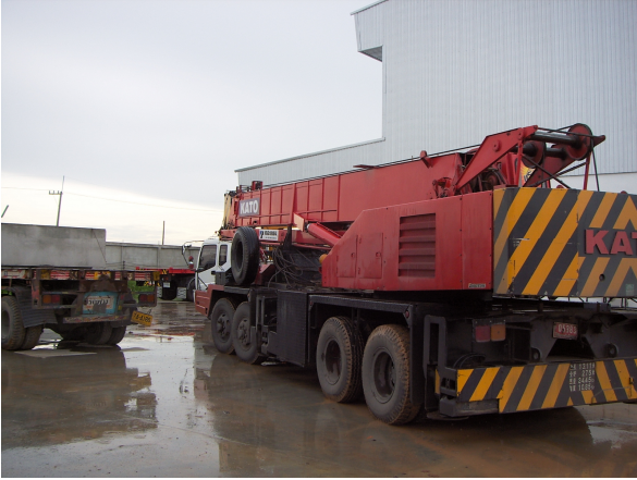
รูปที่ 4 ชั้นส่วนปล่องคอนกรีตและเครนที่ยกติดตั้ง
