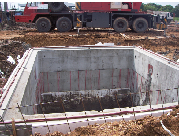
รูปที่ 6 การยื่นของรถเครนที่ต้องใช้แผ่นเหล็กช่วย
