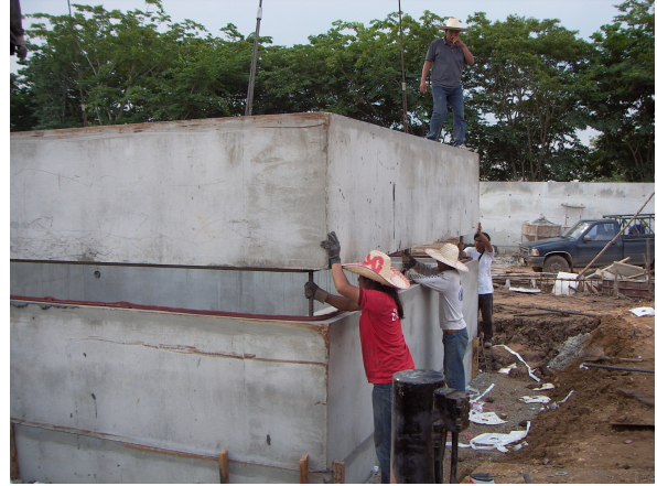
รูปที่ 7 ชั้นส่วนปล่องคอนกรีตกำลังประกอบและติดตั้ง
