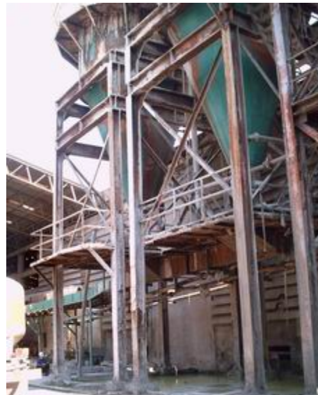
รูปที่ 3 สภาพเสาเหล็กรับไฮโดรเจนที่เสื่อมสภาพจากการกัดกร่อน
