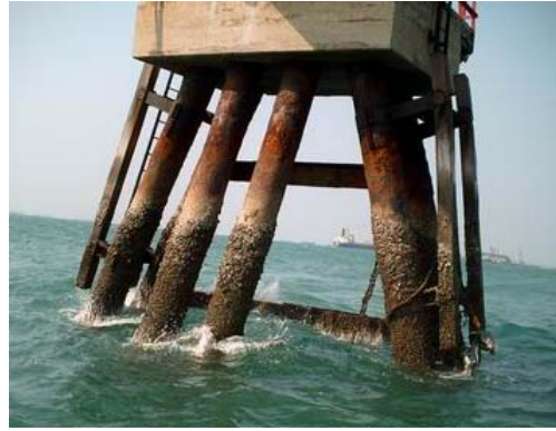
รูปที่ 2 สภาพเสาเหล็กท่าเทียบเรือที่เสื่อมสภาพจากการกัดกร่อน
