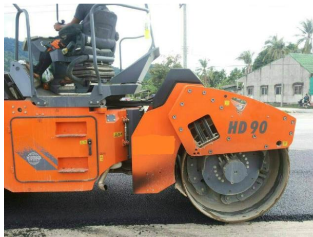
รูปที่ 1 การบดทับส่วนผสมแอสฟัลต์คอนกรีตในสนามด้วยรถบดล้อเหล็กสันสะเทือน
