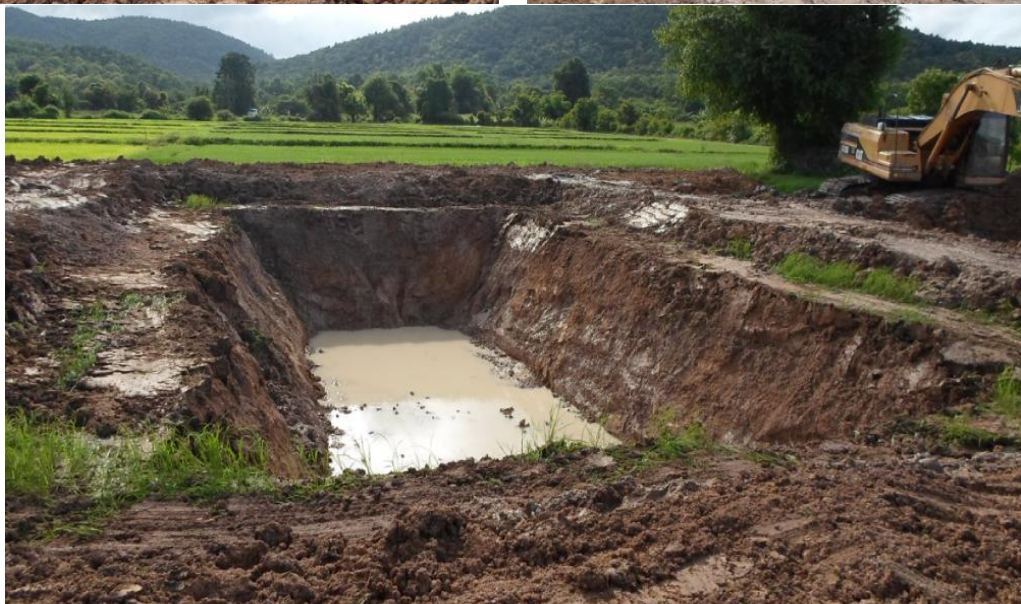
รูปที่ 19 การขุดสระน้ำด้วยรถแบ็คโฮ ในพื้นที่โครงการส่งน้ำและบำรุงรักษาแม่ยม จังหวัดแพร่
