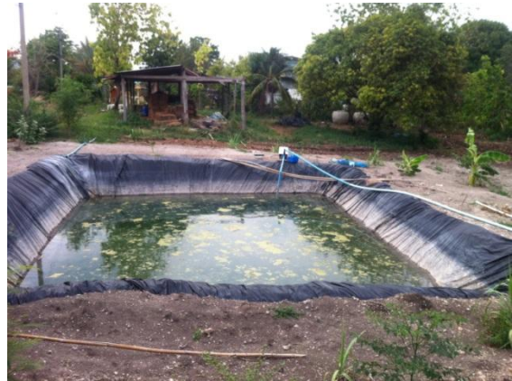
รูปที่ 18 สระเก็บกักน้ำที่ใช้ฟ้าใบรวพื้นสระน้ำ ต.ชัยตะเคียน อ.ชัยบาดาล จ.ลพบุรี
