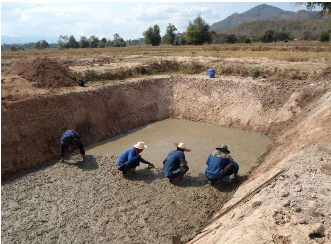
รูปที่ 33 การทำให้คอนกรีตแน่นโดยการตบ ขณะเทพื้นสระน้ำ
