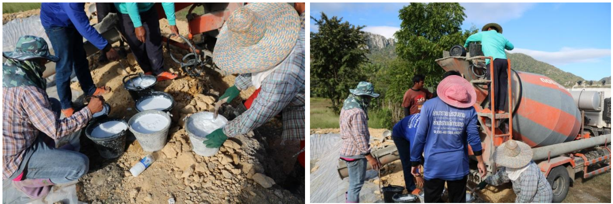
รูปที่ 39 การเตรียมน้ำยาวพาราพสมคอนกรีต
