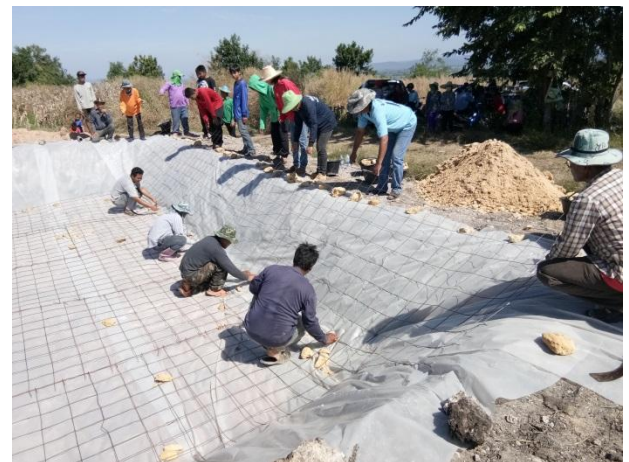
รูปที่ 38 เกษตรกรทำการวางเหล็กเสริมผนังสระน้ำ
