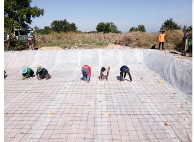
รูปที่ 38 เกษตรกรทำการวางเหล็กเสริมพื้นสระน้ำ
