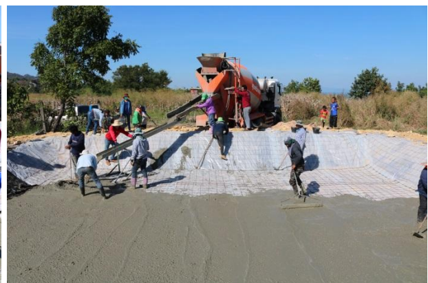
รูปที่ 40 ขั้นตอนการเทพื้นสระน้ำด้วยคอนกรีตผสมน้ำยาวพารา
