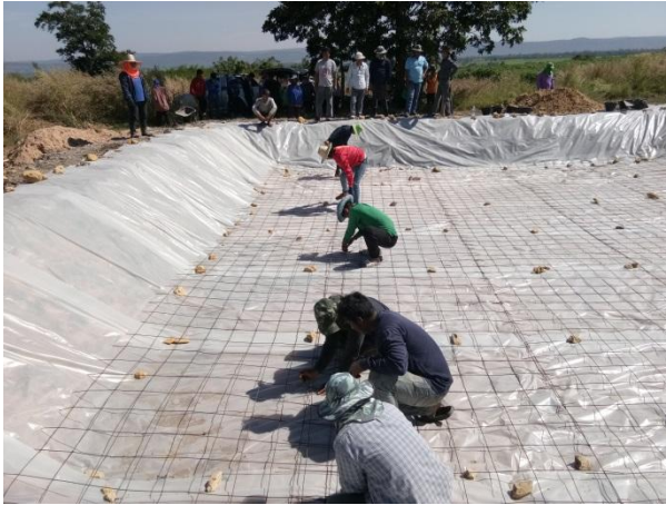
รูปที่ 38 เกษตรกรทำการวางเหล็กเสริมพื้นสระน้ำ
