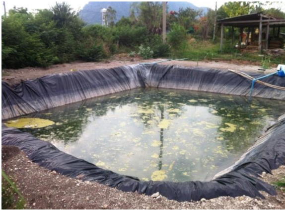
รูปที่ 18 สระเก็บกักน้ำที่ใช้ฟ้าใบรวพื้นสระน้ำ ต.ชัยตะเคียน อ.ชัยบาดาล จ.ลพบุรี
