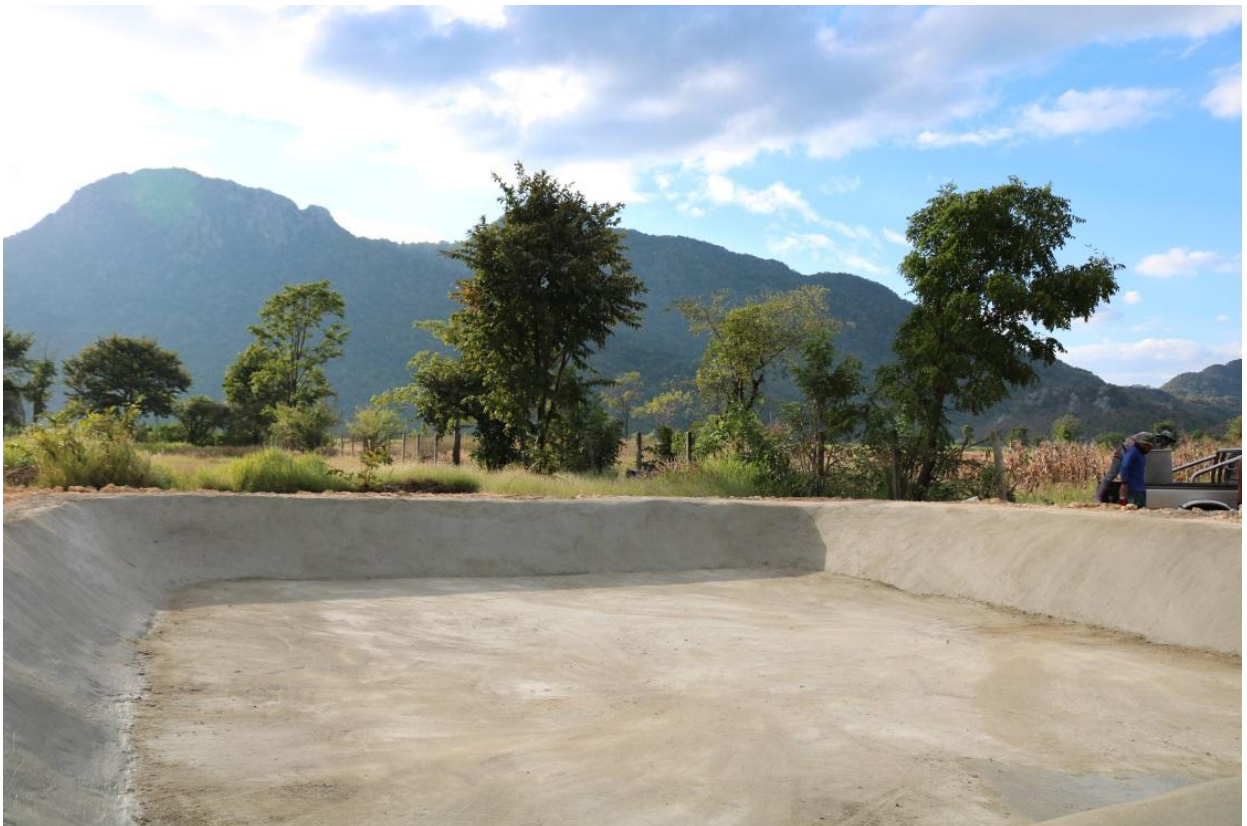
รูปที่ 46 การฉาบผนังสระน้ำโดยใช้คอนกรีตผสมน้ำยาวพารา
