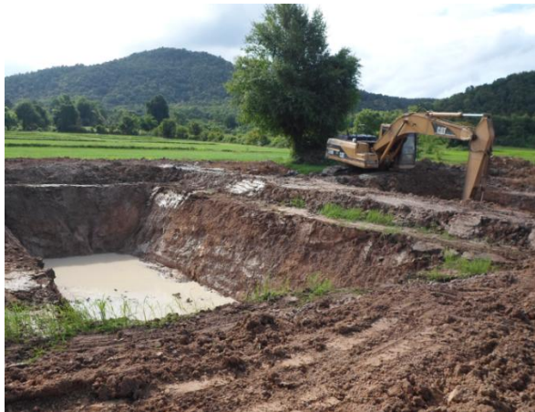
รูปที่ 18 สระเก็บกักน้ำที่ใช้ฟ้าใบรวพื้นสระน้ำ ต.ชัยตะเคียน อ.ชัยบาดาล จ.ลพบุรี
