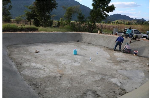
รูปที่ 47 พนังสระน้ำฉาบด้วยมอร์ตาร์ผสมน้ำยาวพาราและได้ทำการขัดผิวหน้าเรียบร้อยแล้ว
