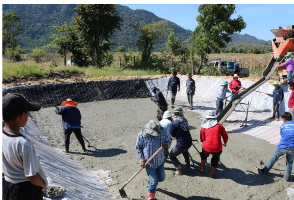
รูปที่ 40 ขั้นตอนการเทพื้นสระน้ำด้วยคอนกรีตผสมน้ำยาวพารา
