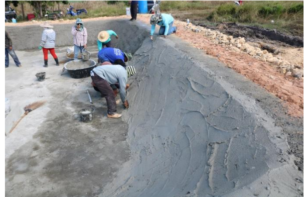
รูปที่ 46 การฉาบผนังสระน้ำโดยใช้คอนกรีตผสมน้ำยาวพารา
