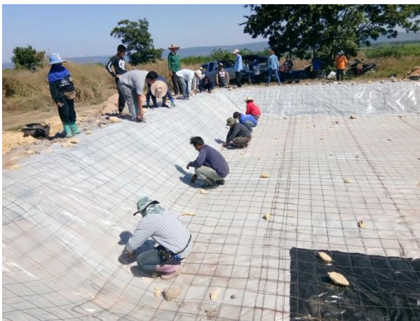
รูปที่ 38 เกษตรกรทำการวางเหล็กเสริมผนังสระน้ำ
