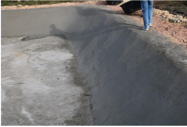
รูปที่ 47 พนังสระน้ำฉาบด้วยมอร์ตาร์ผสมน้ำยาวพาราและได้ทำการขัดผิวหน้าเรียบร้อยแล้ว
