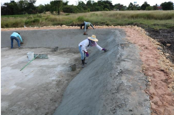
รูปที่ 46 การฉาบผนังสระน้ำโดยใช้คอนกรีตผสมน้ำยาวพารา
