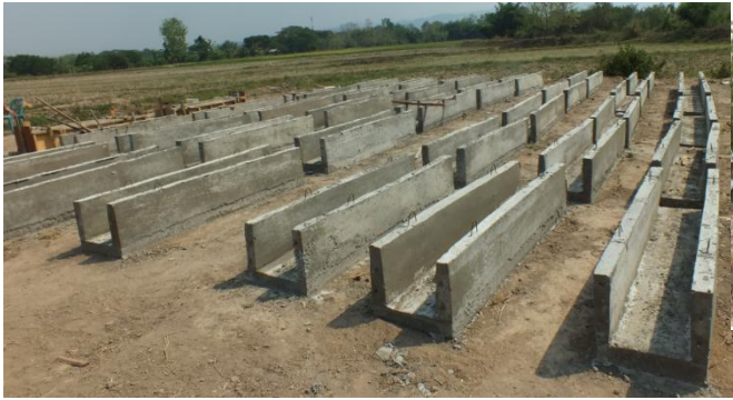
รูปที่ 18 กำหนดความลาดของท้องคู่งน้ำโดยใช้กล้องวัดระดับ
