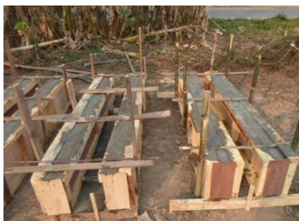
รูปที่ 15 การประกอบแบบหล่อและเทคอนกรีตผสมน้ำยางพารา
