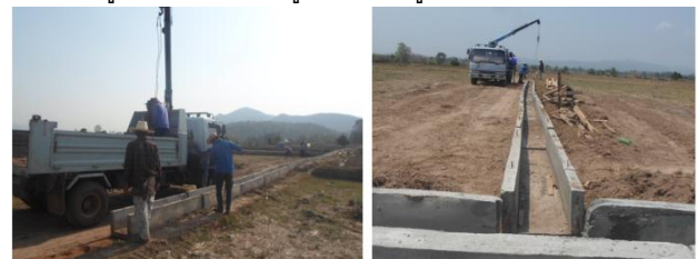
รูปที่ 21 ตัวอย่างคู่งน้ำสำเร็จรูปที่ได้ทำการติดตั้งในแปลงนา
