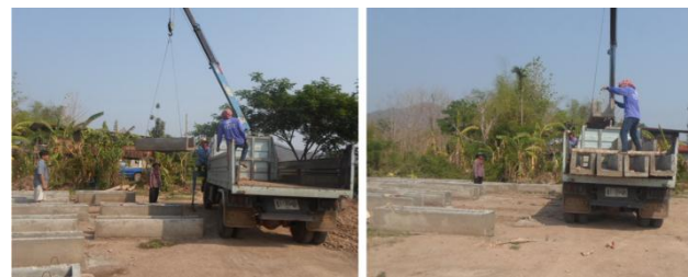
รูปที่ 19 เคลื่อนย้ายคู่งน้ำสำเร็จรูปด้วยรถบรรทุก
