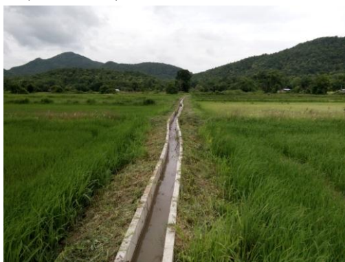
รูปที่ 25 คูส่งน้ำหลังจากก่อสร้างและคูส่งน้ำขณะใช้งาน
