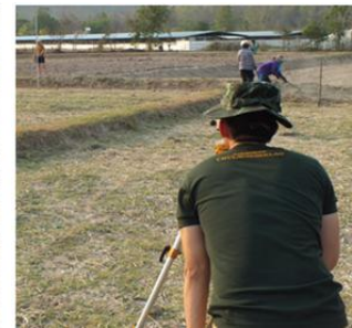
รูปที่ 18 กำหนดความลาดของท้องคู่งน้ำโดยใช้กล้องวัดระดับ
