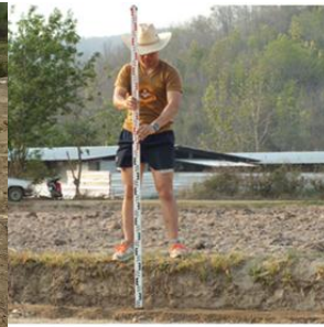
รูปที่ 18 กำหนดความลาดของท้องคู่งน้ำโดยใช้กล้องวัดระดับ
