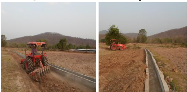
รูปที่ 23 รถแทรกเตอร์ไถเปิดหน้าดินสำหรับทำคันคูส่งน้ำ
