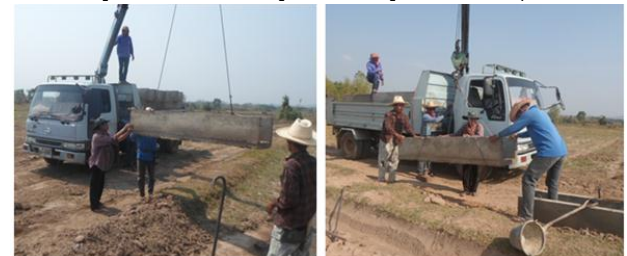
รูปที่ 20 การติดตั้งคู่งน้ำสำเร็จรูปผสมน้ำยาพารา
