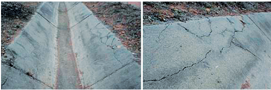
รูปที่ 13 รอยแตกร้าวและรอยสึกกร่อนตามผนังคลองแยกซอย
