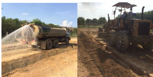
รูปที่ 2 การก่อสร้างชั้นพื้นทางดินซีเมนต์ในแปลงทดสอบ
