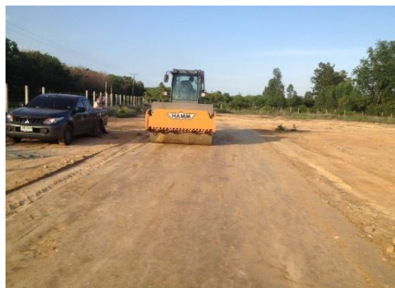
รูปที่ 3 การสร้างรอยร้าวขนาดเล็กบนแปลงทดสอบด้วยรถบดล้อเหล็กขนาด 19 ตัน
